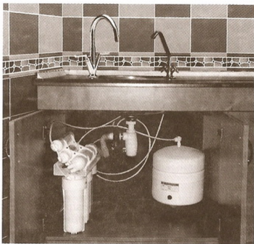
Размещение питьевого фильтра под мойкой
